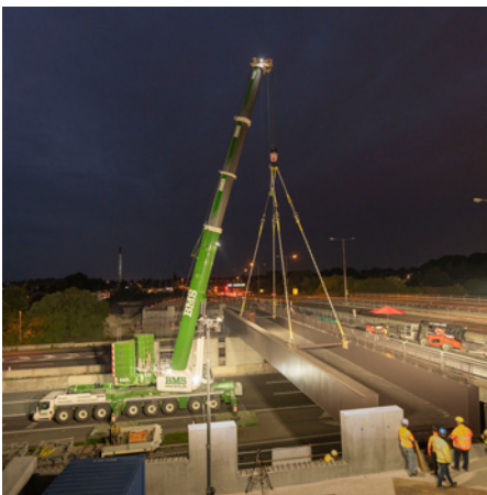
Broløft hvor Buddingevej krydser Motorring 3.
