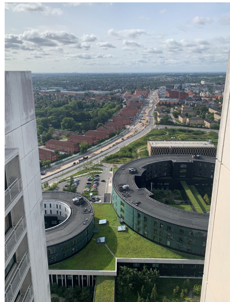
Ring 3 set fra øverste etage på Herlev Hospital (fra nord mod syd).
